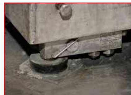
De roestvaststalen weegsensor of krachtopnemer onder de vloeistofdoseertank. Als montagehulpstuk is een trillingdemper op flens, roestvaststaal met neopreen rubber, toegepast
