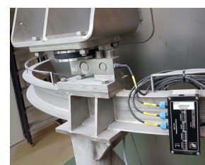
Foto 1. Het op gewicht controleren van de, in een silo opgeslagen, voorraad suiker.
