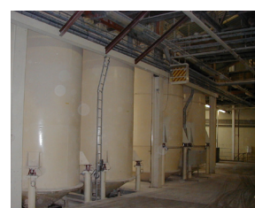
Foto 1. Een silobatterij voor de opslag van meerdere soorten meel.
