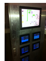
Foto 8. Een operator terminal, gecombineerd met een blindschema.
