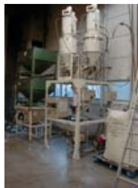
Foto 3. Het realiseren van een continue materiaalstroom vanuit twee wegers.
