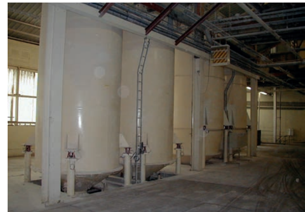
Afb. 2 Wegende silo's voor de belading van bulkwagen-compartimenten
